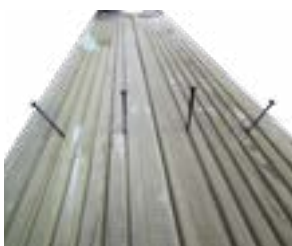
Fixing of the edges Colocación de las playas Fixation des margelles Befestigung der Ränder Fissaggio dei bordi Bevestiging van de randen Fixação dos bordos
