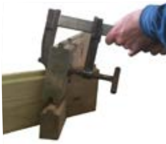
Loose board • Tabla suelta • Madrier voilé • Loses Brett • Tavola libera • Losse plank • Tábua solta
